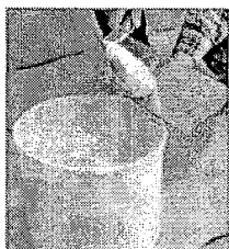
Силикатните, силиконови и полимерните мазилки се доставят във вид на готов пастообразен разтвор, който преди употреба се разбърква с електрическа бъркалка на бавни обороти. При необходимост може да се добави и малко вода
