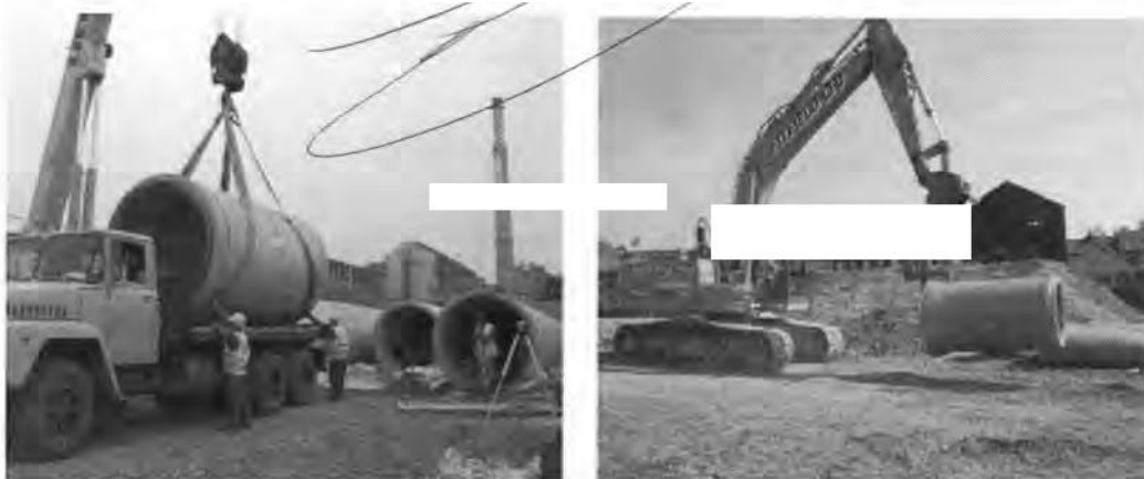
Снимки 1-2: Начини за правилен захват на бетонови/стоманобетонови тръби
