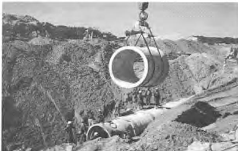
Снимка 1-3: Инсталиране на бетонни тръби
